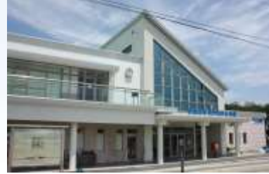
東松山市震災復興伝承館 (写真提供: 東松山市震災復興伝承館)
